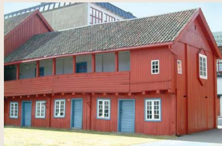
Landfalløya 24 i Drammen - sidebygning trolig bygd før 1840. Dersom det planlegges fasadeendring må kommunen varsle fylkeskommunen. Foto: Turid Kolstadløyen.
