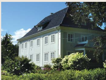
Disponentboligen ved Hellefos fabrikk i Øvre Eiker - et eksempel på bygning som ikke er registrert i SEFRAK men som har verneverdi. Foto: Åse Marit Rudlang.
